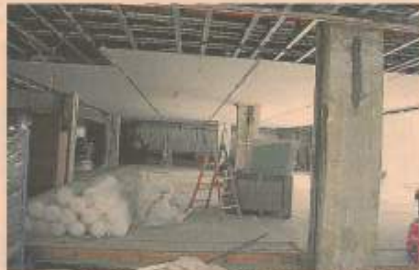
servar en la primera imagen, del 1 de abril. El 15 de abril se estaba empezando a instalar el techo y faltaba el sue-
