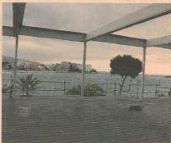
▲ Terraza del hotel el 8 de abril, todavía sin techo.
