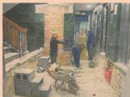
▲ En la zona de la escalera, se bajó el nivel del suelo y de los ascensores y se instalaron tres peldaños nuevos. El cambio del 1 de abril al 4 de mayo es radical.
