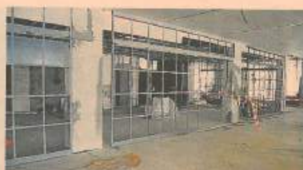
estaba casi sin empezar. El 8 de abril ya se había instalado el cerramiento de metal. Después de la pintura se em-
