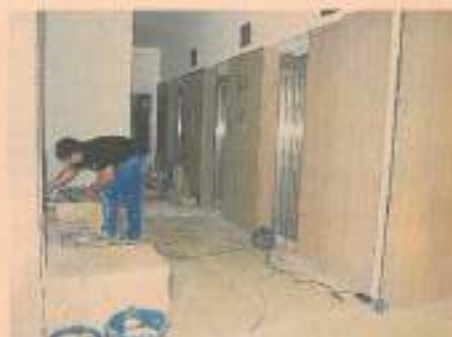
▲ En la zona de la escalera, se bajó el nivel del suelo y de los ascensores y se instalaron tres peldaños nuevos. El cambio del 1 de abril al 4 de mayo es radical.
