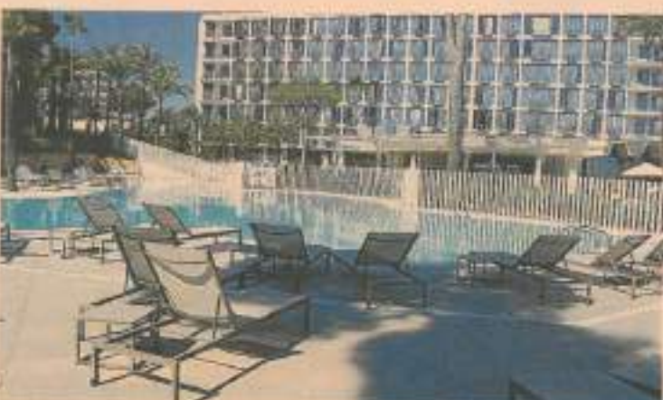
▲ La terraza todavía tenía las baldosas antiguas el 1 de abril. El 22 de abril, ya con las nuevas baldosas, se podían contar a 10 hombres trabajando en la piscina, cuyo color pasó de azul a blanco. Igual que la valla. El 4 de mayo ya estaba completamente lista.
