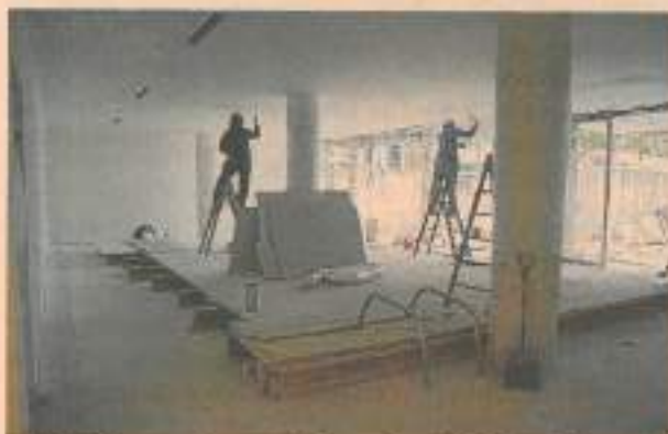
▲ En la zona de spa y gimnasio, el día 1 de abril, con la piscina interior cubierta, se estaba adecuando el te-
