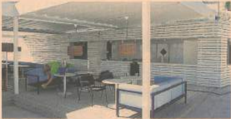
▲ La zona de cocinas de la piscina sufrió un cambio sustancial desde el 8 de abril (primera foto). Se instalaron paneles de madera y se pintó de blanco (29 de abril). El 4 de mayo, con mobiliario.
