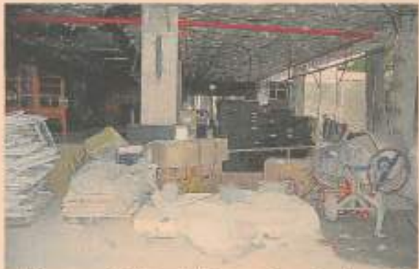
▲ La zona de hall se utilizó como almacén de material durante la fase inicial de la obra, como se puede ob-
